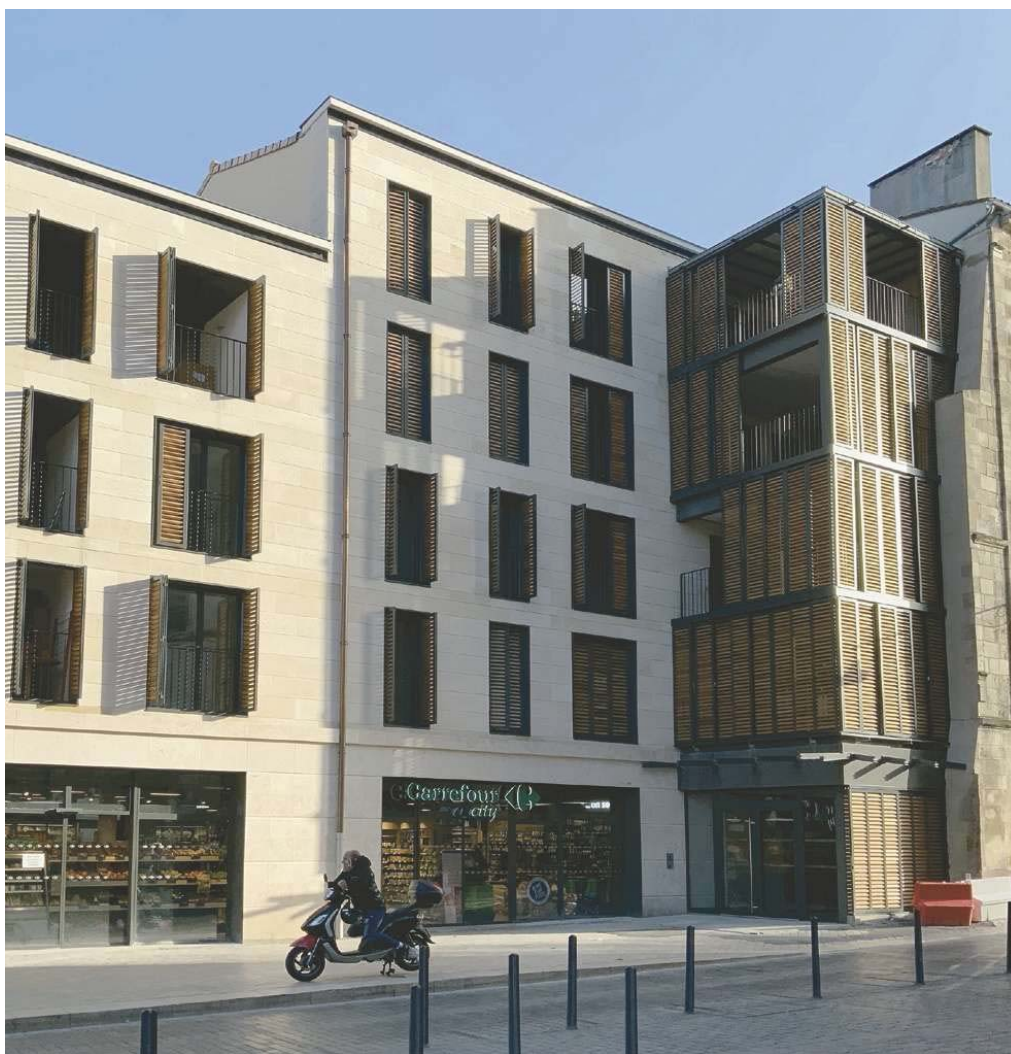
PHOTO © THIERRY MORIN ARCHITECTE
