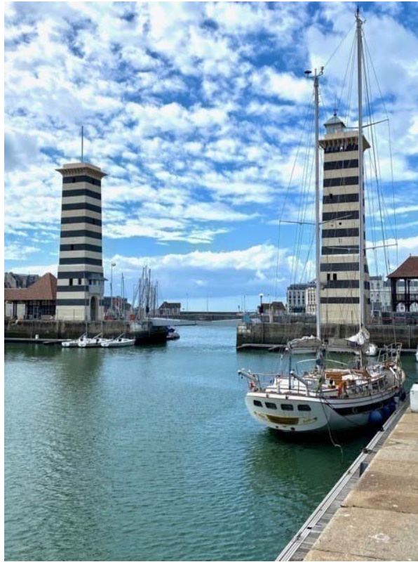
Les deux obélisques sont désormais sortis de terre. (©Ville de Deauville)
